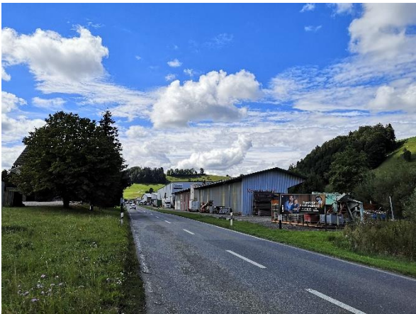
Abbildung 3: Luzernstrasse, Blick Richtung Huttwil
