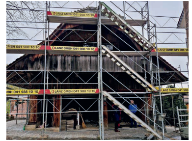
Der Pfarrspsycher ist für den Umbau eingerüstet.
