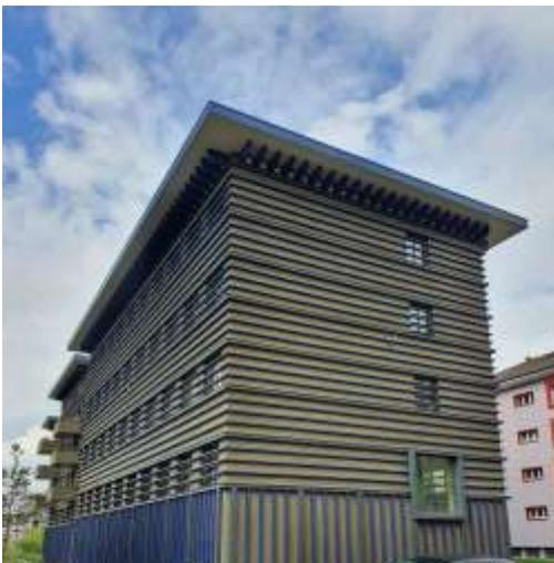
Dabei ging er vom ersten Moment an innovative Wege. So war etwa das erklärte Ziel, dass das gesamte Gebäude von späteren Generationen ohne grossen Aufwand in die Einzelteile zerlegt und jedes einzelne Element in gleicher oder ähnlicher Funktion weiterverwendet werden kann – und sei es nur schon als Energielieferant in Form von Brennholz.
